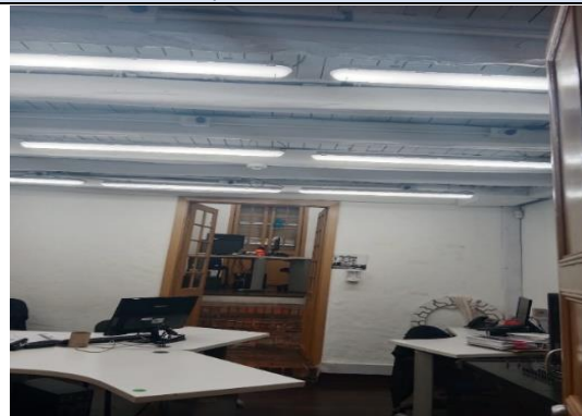
Ilustración 77. Reemplazo de herméticas – Casa Siete balcones
