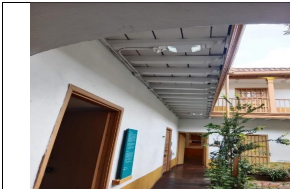
Ilustración 92. luminarias de emergencia – Casa Siete balcones
