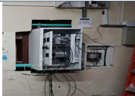
Ilustración 43. Conexión circuitos eléctricos
