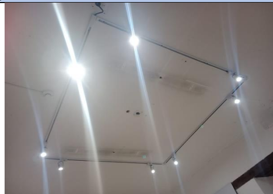
Ilustración 79. Reemplazo de herméticas – Casa Samano
