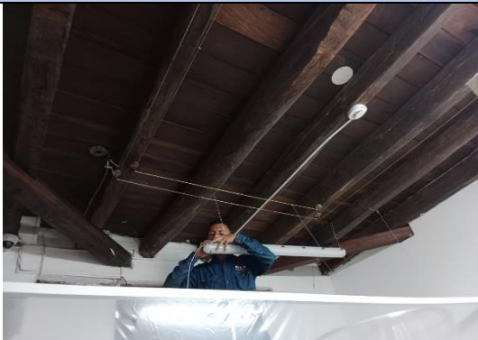
Ilustración 74. Reemplazo de herméticas – Casa Samano
