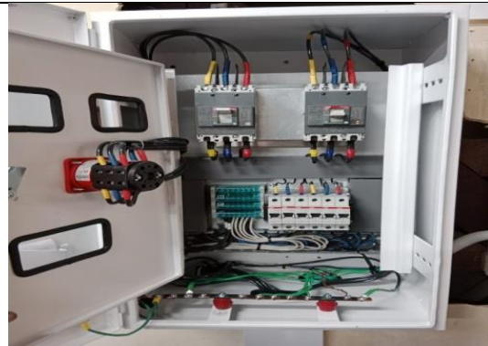
Ilustración 45. Tablero Bypass
