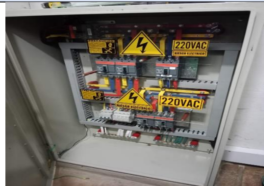
Ilustración 5. Tablero BYPASS nuevo
