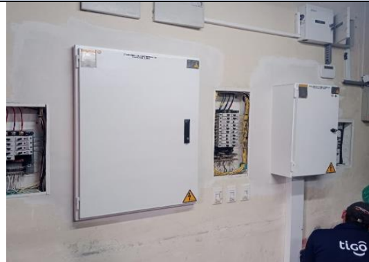
Ilustración 30. Instalación tablero general
